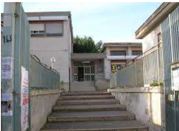
Plesso “D. Milani” Via Architetto Licata s.n.c.
